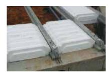
1. Dans le cas d'une pose avec étais, ceux-ci doivent être placés avant le coulage sous un bastaing posé à plat au contact de la sous-face des entrevous, perpendiculaires aux poutrelles.
