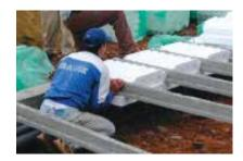
2. Après la pose des entrevous, procéder à la mise en place des chaînages, du treillis soudé et des chapeaux qui doivent être fixés sur le treilli soudé au droit de chaque poutrelle. (Type de chapeau défini sur le plan de pose). Le béton de dalle de compression sera de type B25 et pourra être autoplaçant. Respecter l'épaisseur de béton de la dalle de compression indiquée sur le plan
