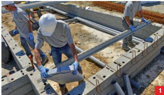
Pose des poutrelles RECTOR®, le THERMOREFEND® sert de gabarit de pose pour régler les entraxes
