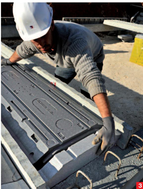
L'entrevous RECTOSTEN® s'emboîte dans le THERMOREFEND® : pose sécurisée et garantie d'étanchéité du plancher au coulage
